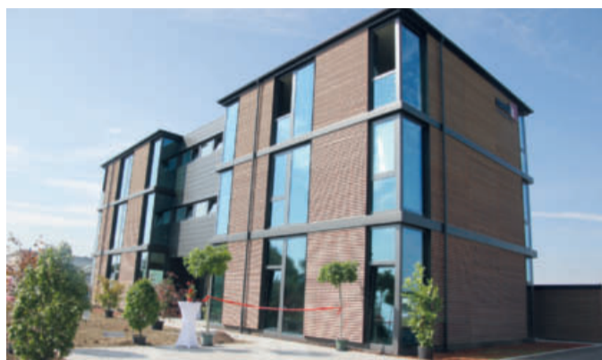
Das moderne Gebäude passt zu dem jungen Team des wachsenden IT-Dienstleisters. Essendi IT will sich künftig deutlicher in der Region präsentieren.
